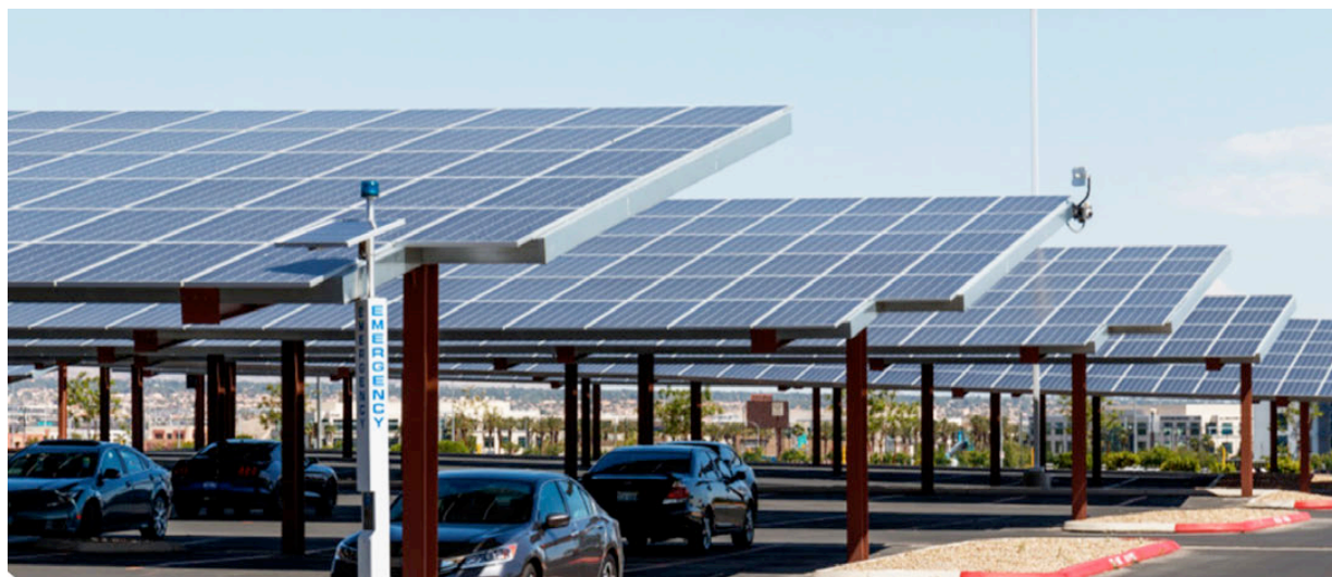
Exemple d'ombrière photovoltaïque sur une aire de stationnement.
